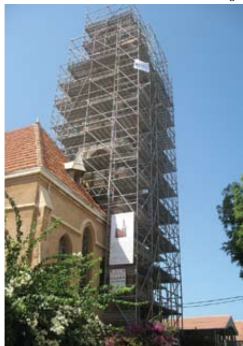
Arbejdet er i gang udenfor – indenfor fungerer kirkelivet som sædvanligt.
